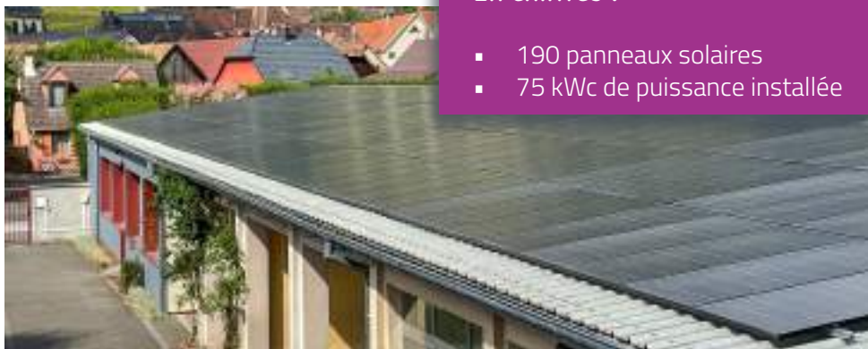
Panneaux photovoltaïques sur le toit de l'école primaire de Lapoutroie
